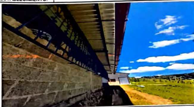
Foto 7: han mejorado las condiciones de las aulas, ya que actualmente ya no presentan problemas.
