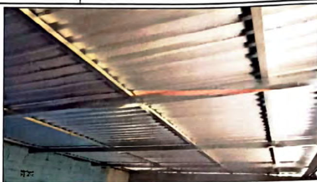
Foto 2: la estructura de techo quedo muy presentable y sobre todo ya no presenta goteras o problemas propios de un entechado.
