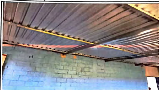
Foto1: la diferencia de entechado de aulas es notorio despues de culminar los trabajos.
