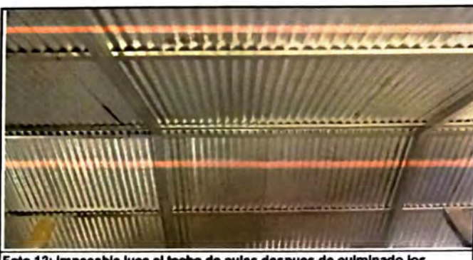
Foto 12: Impecable luce el techo de aulas después de culminado los trabajos.
