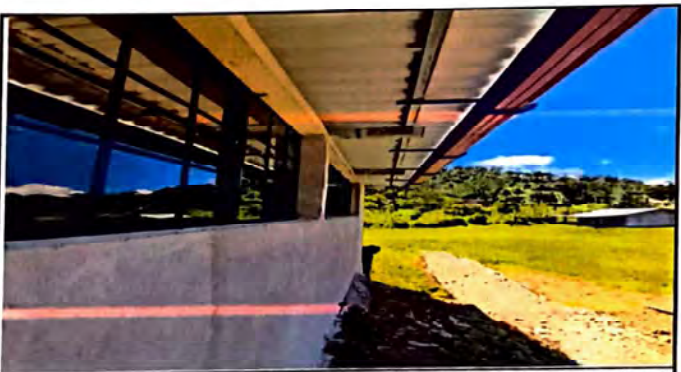
Foto 15: luce muy hermosa aula que se cambio el entechado, ventanales, puertas y piso.
