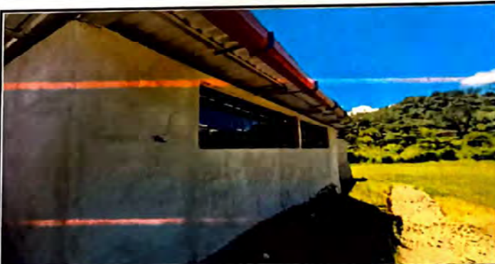
Foto 16: aula que excelente medida despues de la modificación que se le hiciera.
