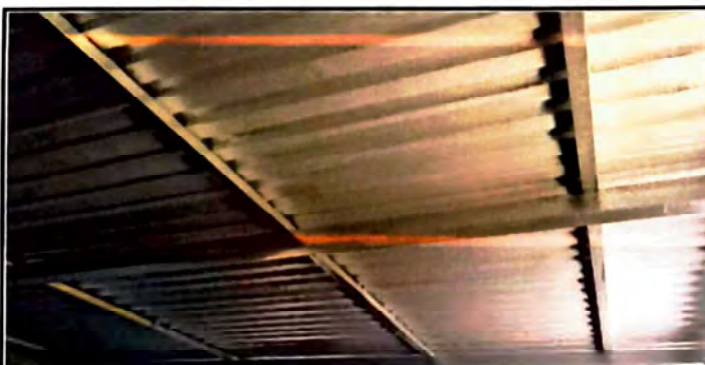
Foto 18: techo presentable con materiales de excelente calidad, se nota el cambio realizado.
